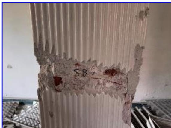
A seguito di rimozione puntuale di intonaco il pilastro risulta essere in mattoni pieni.
