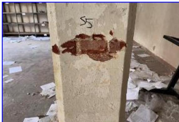
A seguito di rimozione puntuale di intonaco il pilastro risulta essere in mattoni pieni.
